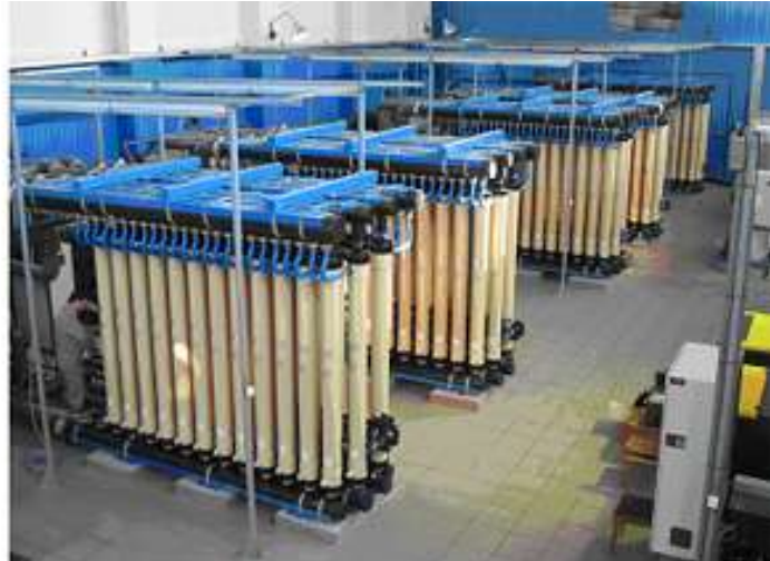
Шесть типовых систем для получения 1000 м 3 /ч питьевой воды из озера (г. Озерск, Челябинская обл., Россия)
