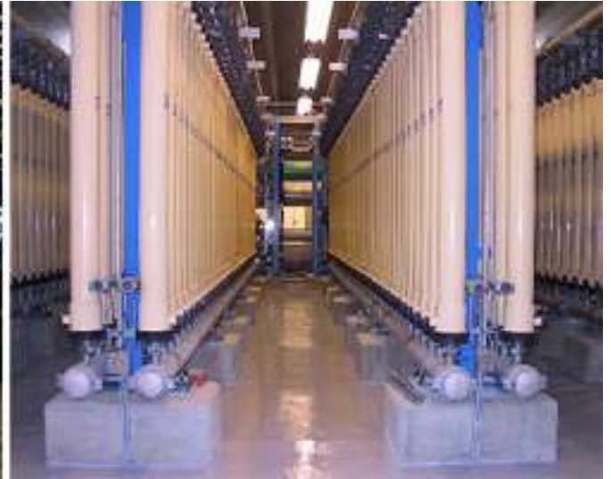
Нетиповая система для получения 1572 м 3 /ч питьевой воды из поверхностного водоисточника (г. Вестминстер, США)
